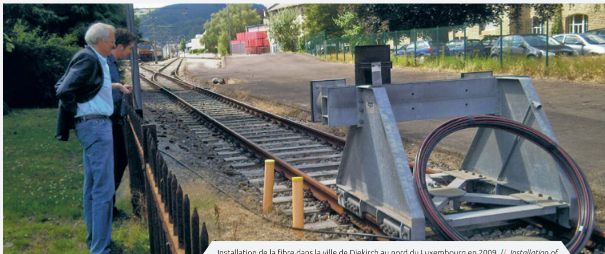
Installation de la fibre dans la ville de Diekirch au nord du Luxembourg en 2009 // Installation of fibre in the town of Diekirch, north Luxembourg, in 2009
